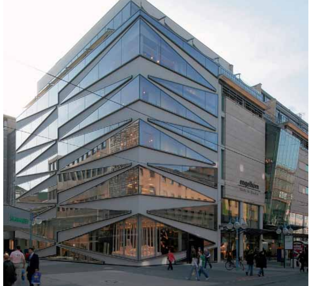
Architektonisches Glanzstück der Mannheimer Planken: Engelhorn acc/es und Engelhorn Mode im Quadrat.
