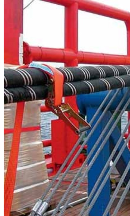
Kabelverlegung auf hoher See vor einer
