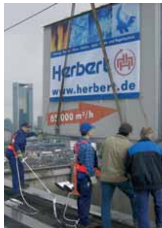
Herbert-Monteur beim Einbau eines Lüftungsgregats. Bild: Herbert
