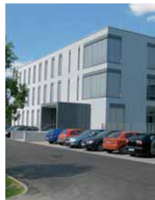
Das neue Bürogebäude am Standort
