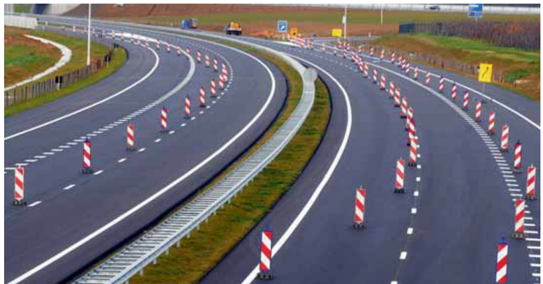
Ab bestimmten Schwellenwerten muss die öffentliche Hand ausschreiben. Dies gilt für Liefer- und Dienstleistungen (VOL) genauso wie für den Bau von Autobahnen, die unter die sogenannten Bauleistungen (VOB) fallen. Bild: Fotolia
