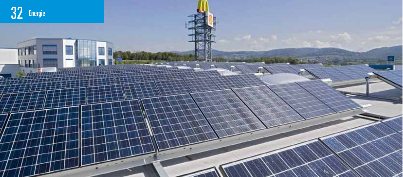
Eine Goldbeck-Solar-Anlage auf dem „Apart factory store“ in Hirschberg. Die 2006 in Betrieb genommene Anlage produziert 39 kWp.
