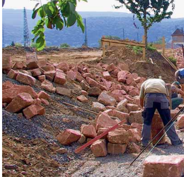
Die Bauarbeiten für das neue Viertel „Bahnstadt“ haben begonnen. Dort entstehen Gewerbeimmobilien und 2500 Wohnungen. Bild: EGH
