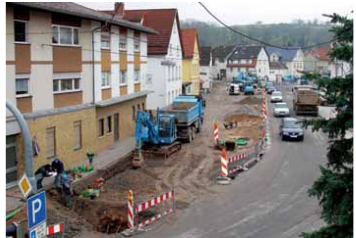
Im Ortskern entlang der Meckesheimer Friedrichstraße rollten noch bis ins vergangene Jahr hinein Lastwagen und Bagger, ... Bild: Meckesheim
