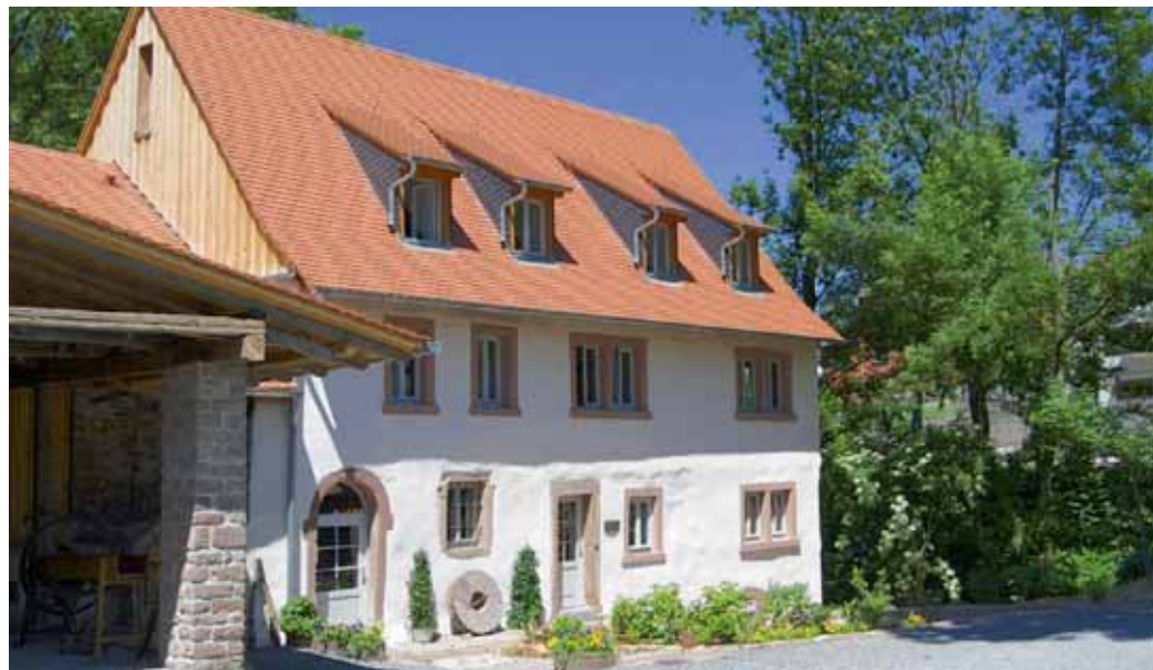
Die Fondsbroker AG wollte nicht länger im typischen Finanzdienstleister-Glaspalast residieren. 2005 ist sie daher in die Apfelbachmühle in Hirschberg gezogen. Zuvor wurde die 680 Jahre alte Mühle aufwendig saniert. Bilder: Fondsbroker AG
