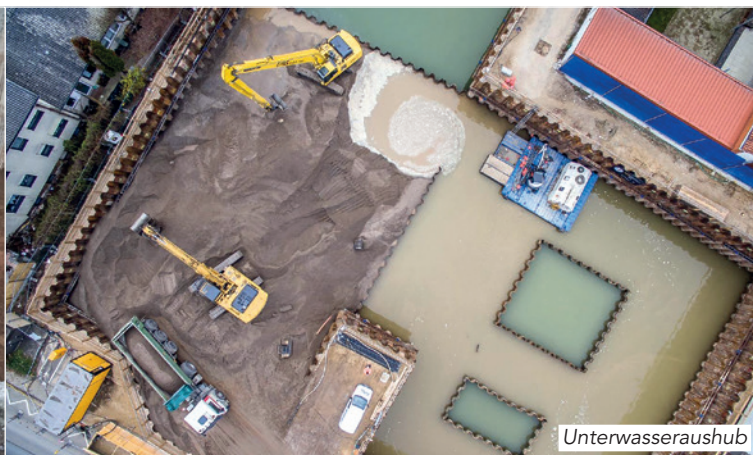
Spundarbeiten innerhalb der Baugrube, Tiefe 15 m
